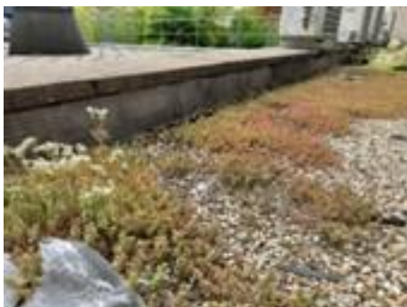
Couvertines béton sur la toiture terrasse R+1
