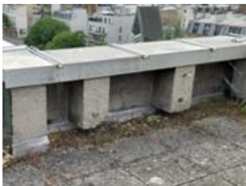
Acrotère mise à jour sur le bâtiment de la Sorbonne 91, présentant des dispositions similaires
