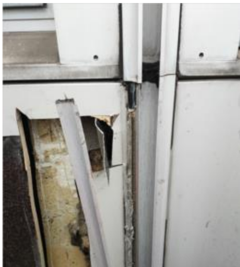
Couvre-joints de finition des épines du mur-rideau
